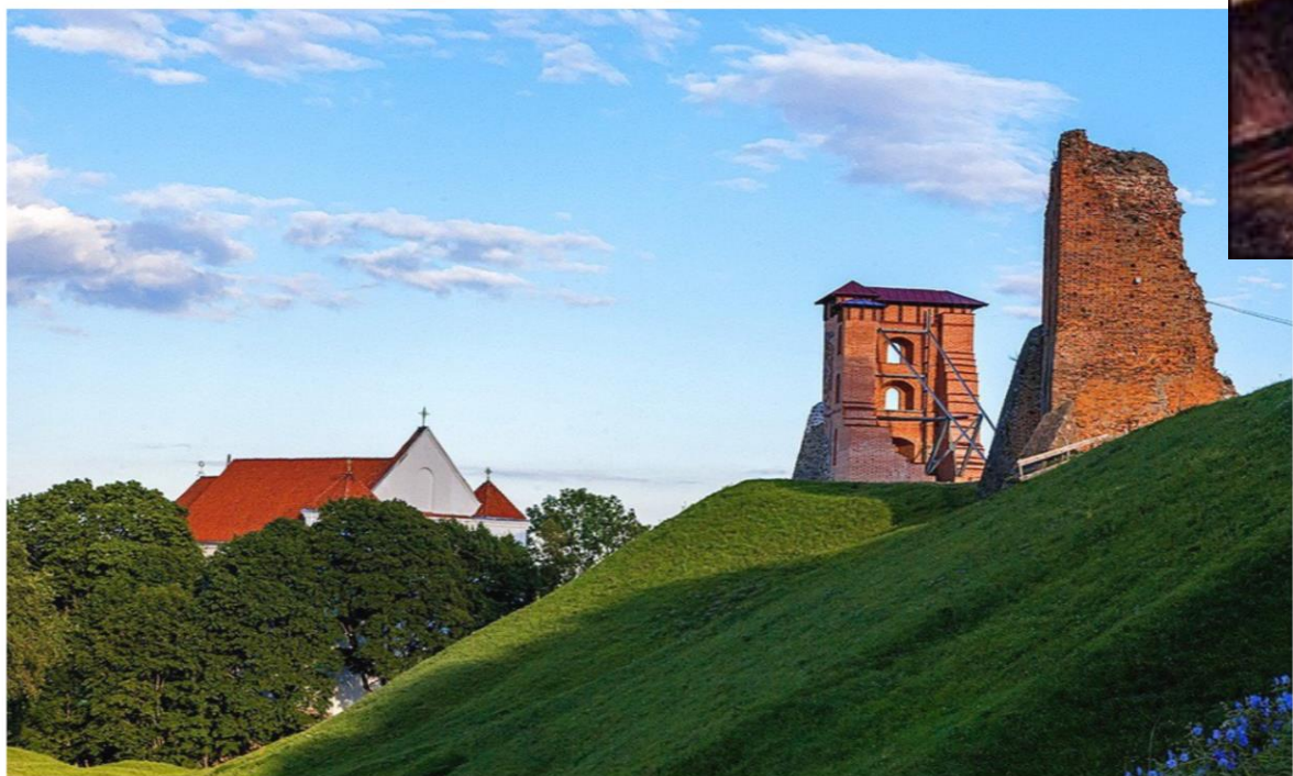
Сегодня на замке проводятся консервационные и реставрационные работы.
