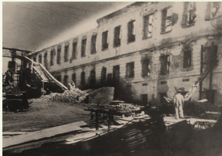
Восстановление разрушенного здания табачной фабрики. 1944 г. ГАГр. НСБ № 2210.
