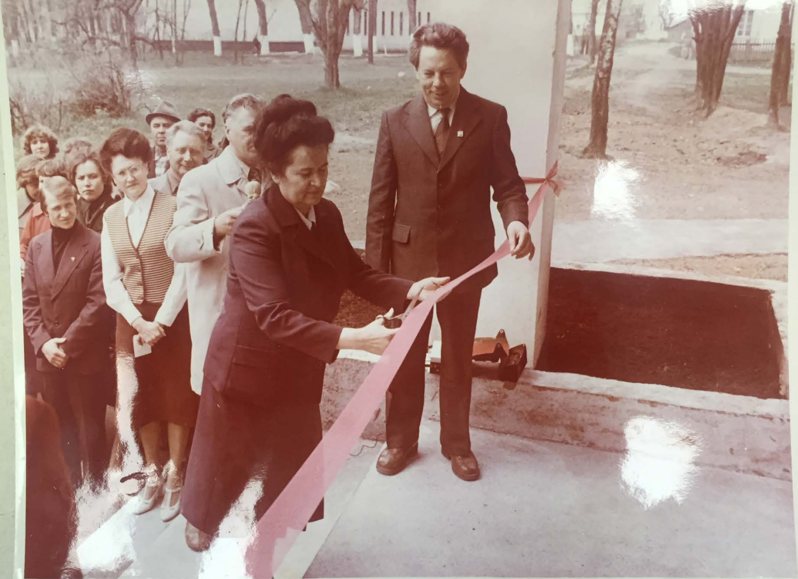
Красную ленту у входа в здание отдела ЗАГС перерезает первый секретарь Дилского ГК КПБ Попова Н.И.
